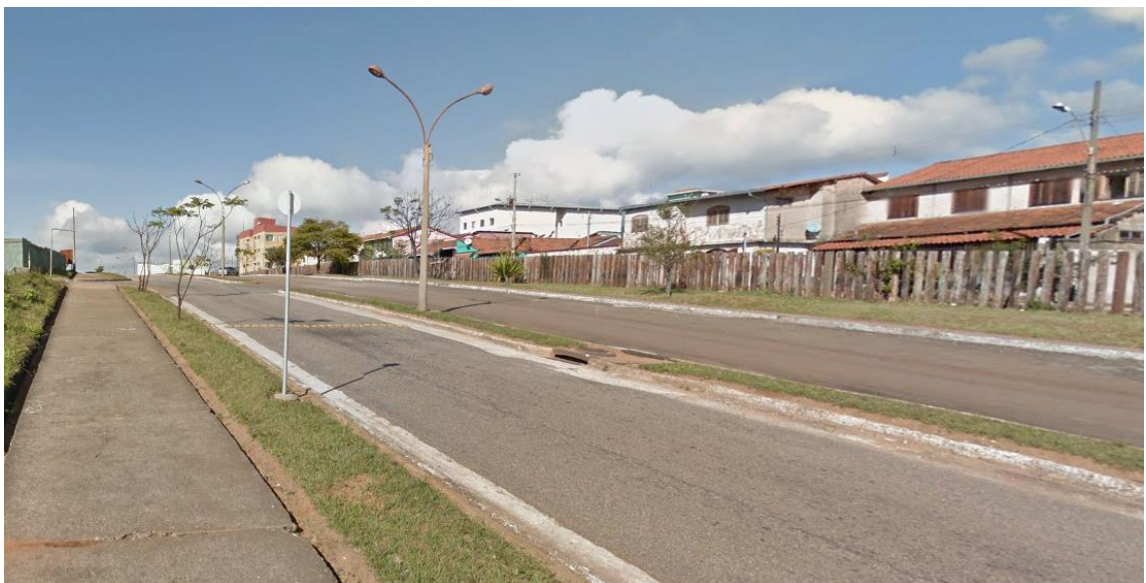
Figura 9: Infraestrutura viária do campus Morro do Cruzeiro
