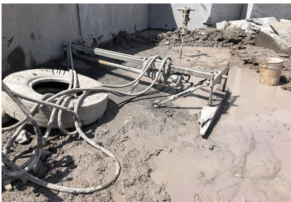
Figura 12: Perfuração do maciço.
