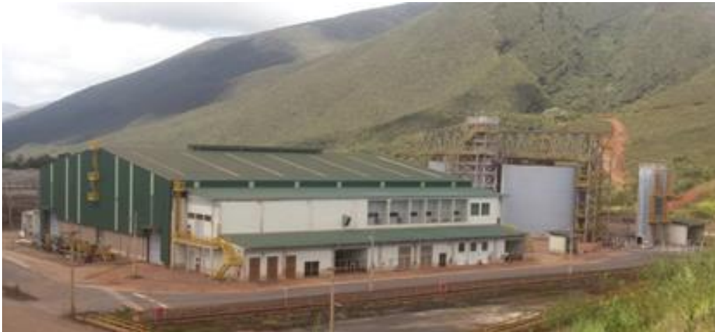
Figura 2.4: Estação de bombas VI da Samarco.
