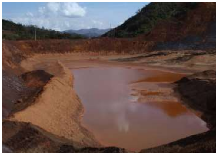
Figura 38 - Sump para drenagem da água (Sousa, 2011)
