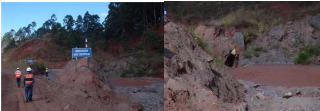
Figura 37 - Saída nas laterais das vias direcionando a drenagem e aspecto construtivo da drenagem nas saídas laterais (Sousa, 2011)
