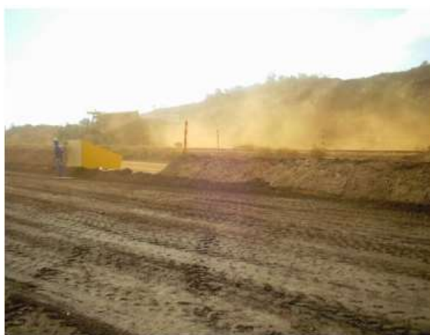
Figura 9 - Precárias condições de tráfego impostas a uma estrada de mina, devido à excessiva geração de pó (Oliveira Filho et al. , 2010b)
