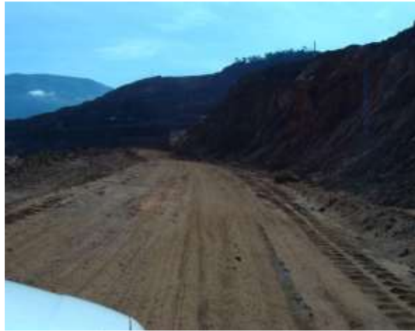
Figura 39 - Bermas para direcionamento de drenagem (Sousa, 2011)
