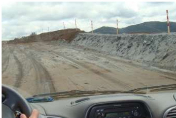
Figura 29 - Leiras de proteção laterais construídas em minério e estéril (Sousa, 2011)
