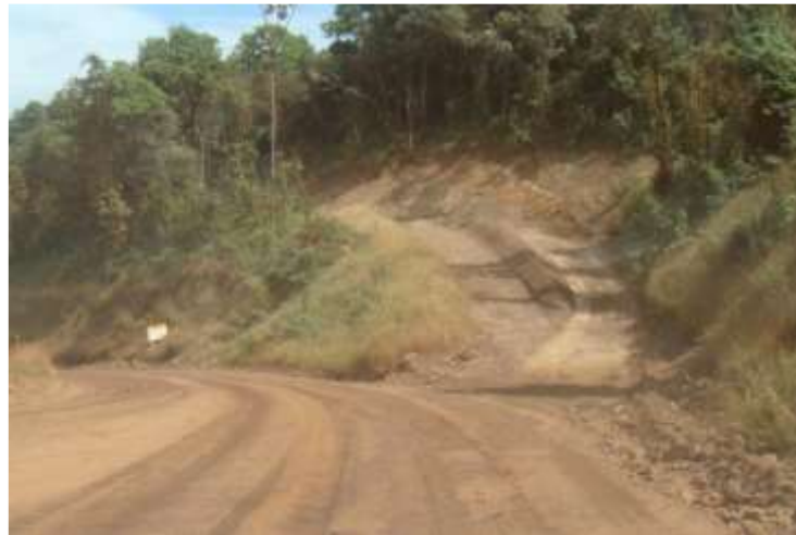
Figura 32: Saída de emergência (Sousa, 2011)
