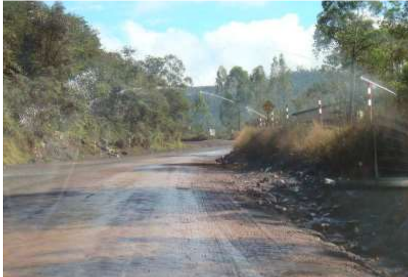
Figura 42 - Aspersão fixa ao longo da extensão de uma estrada de acesso principal às minas(Sousa, 2011)
