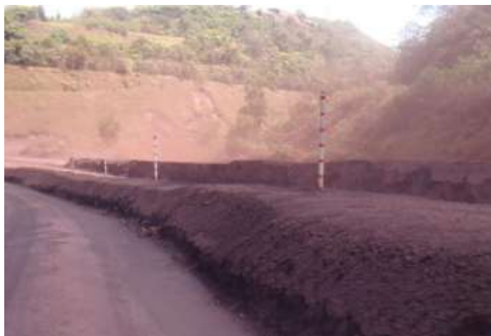
Figura 30 - Leiras de separação entre acessos de equipamentos pesados e leves (Sousa, 2011)
