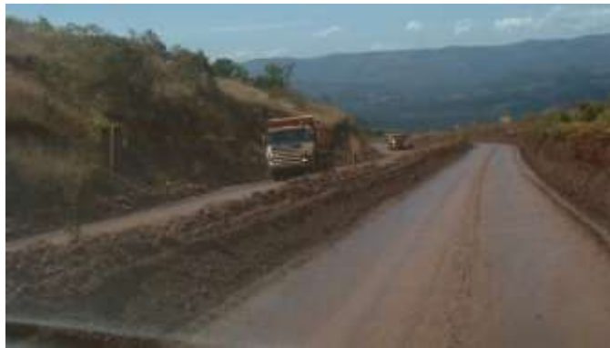
Figura 28 - Leiras de proteção centrais (Sousa, 2011)
