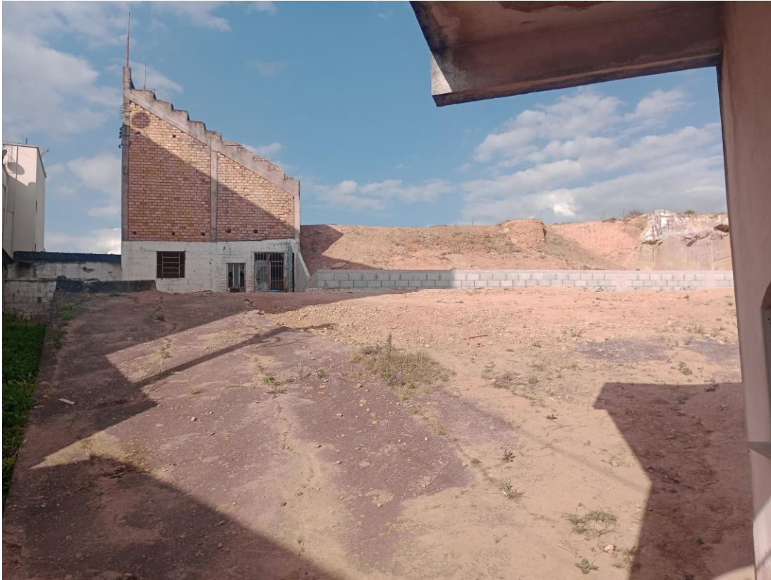
Arena Santa Teresa, interditada em 2008.
