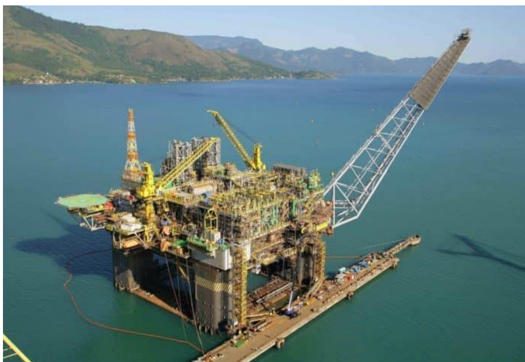
Figura 2-8: Plataforma da Petrobras P52
