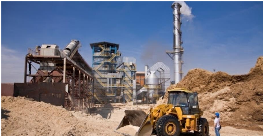
Figura 2-10: Bagaço de cana para produção de energia elétrica
