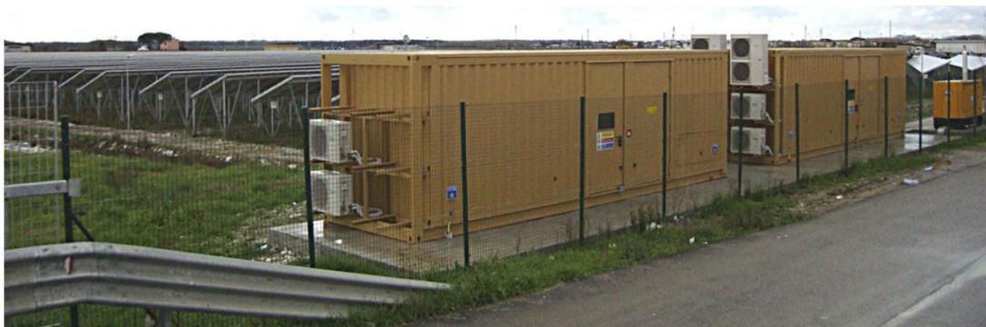
**Figura 10** – Imagem do inversor e recipiente de armazenamento
