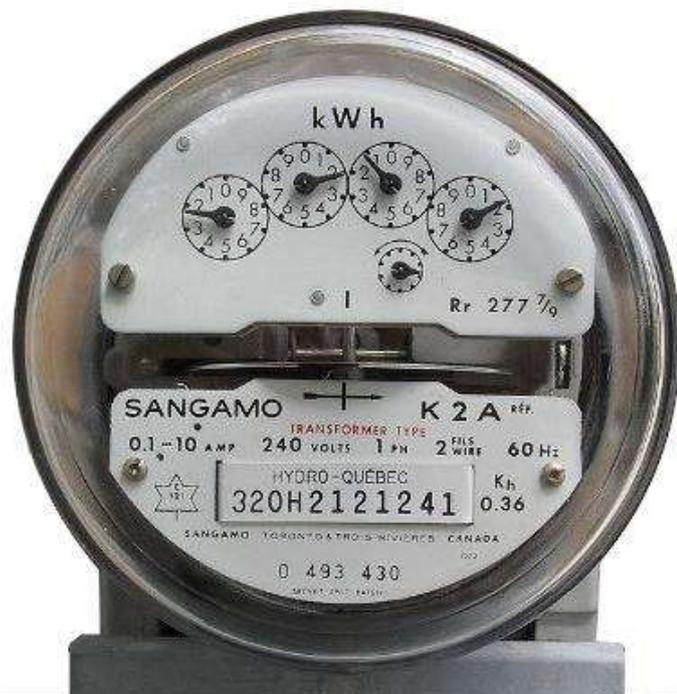
Figura 3 - Medidor de Consumo Elétrico Analógico
