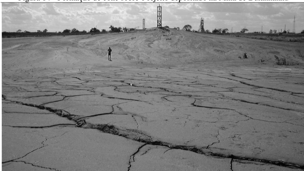
Figura 14 - Formação de cone sobre o rejeito depositado na Mina de Bulanhanhu
