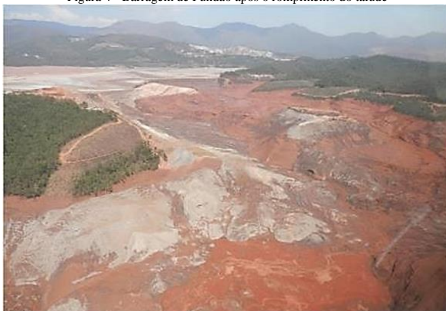
Figura 4 - Barragem de Fundão após o rompimento do talude
