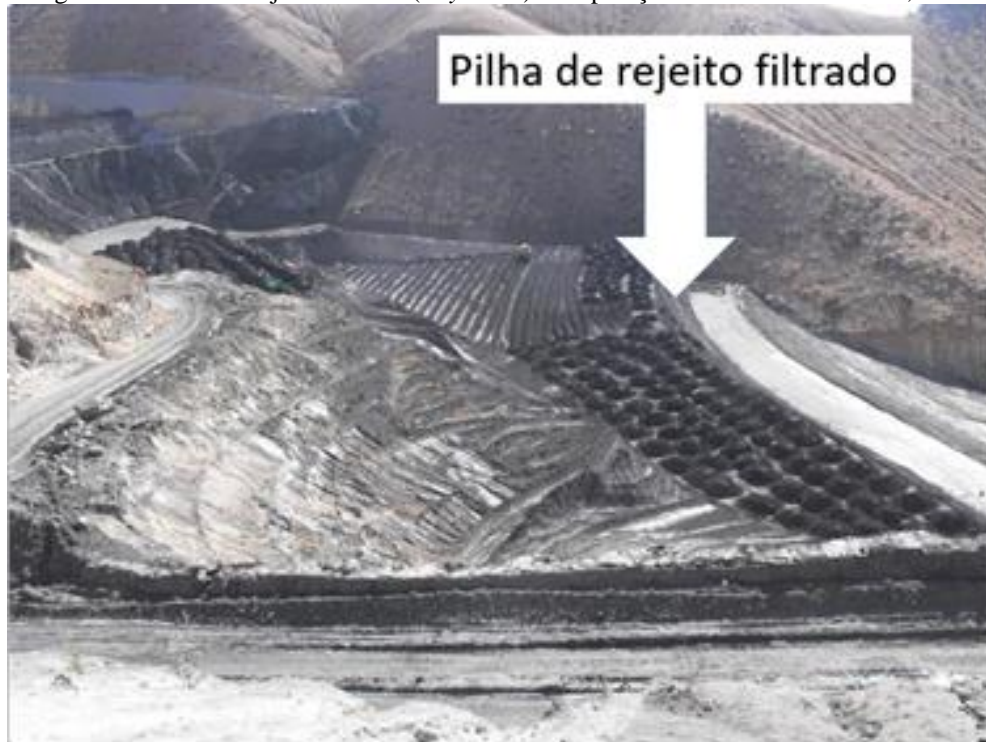
Figura 16 - Pilha de rejeito filtrado ( Dry stack ) em operação na Mina Cerro Lindo, Peru
