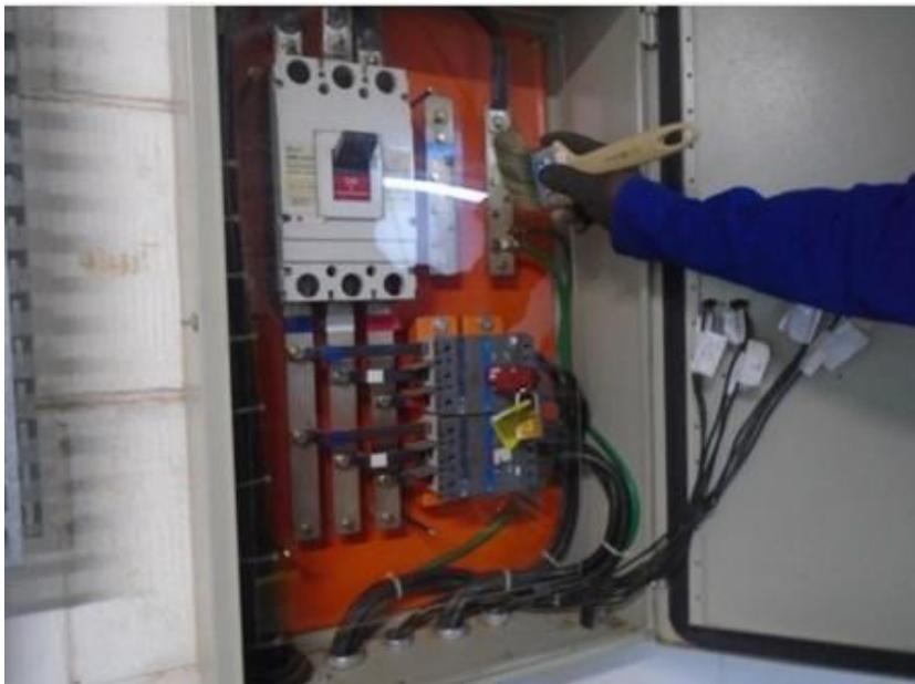
Figura 10:Manutenção em Inversor de Frequência do desagregador.
