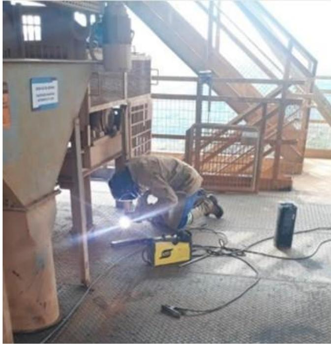
Figura 11: Manutenção em chapa de piso da usina.
