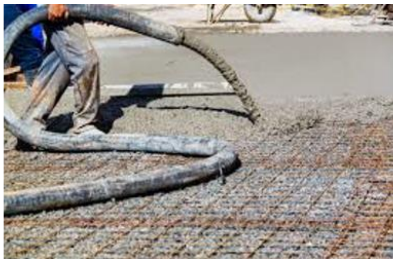
Figura 21 - Mangueira de bombeamento. Fonte: APL Engenharia (2023).
