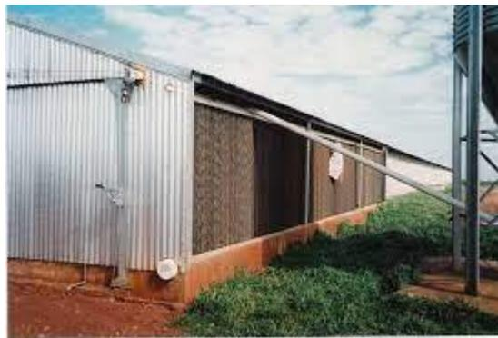
Figura 10: Aviário utilizando o sistema de placas evaporativas
