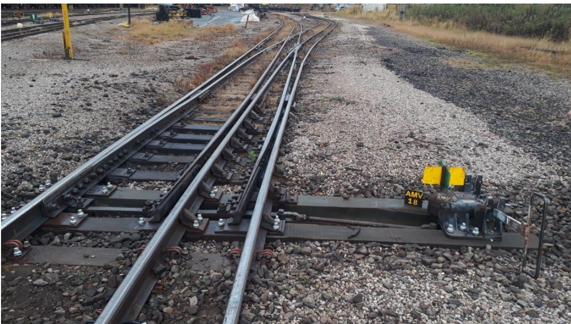
Figura 7: Aparelho de Mudança de Via – AMV
