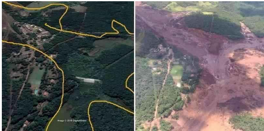
IMAGEM 2 – BARRAGEM DO CÓRREGO DO FEIJÃO ANTES E DEPOIS DO ROMPIMENTO
