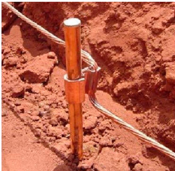
Figura 1 – Constituição de um aterramento.
