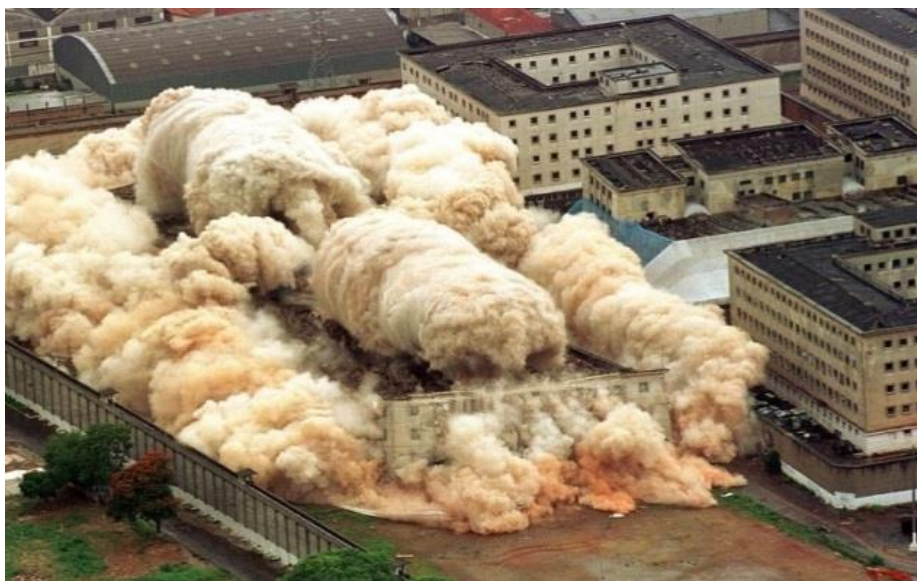
Figura 9: Implosão do Carandiru
