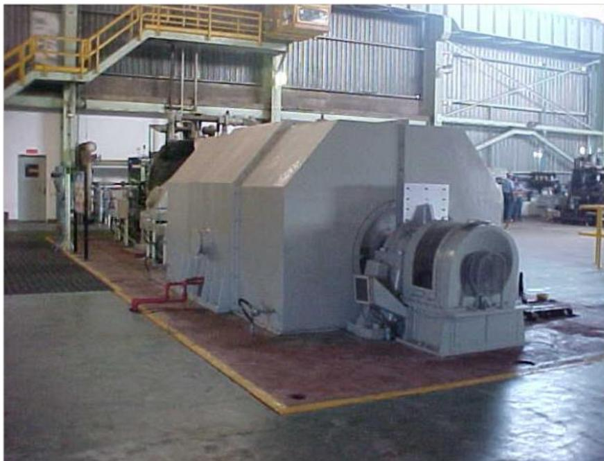
Figura 15: Foto da turbina a vapor Mitsubishi modelo 7EL-7 com vista externa do lado do gerador.
