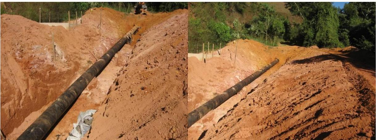
Figura 28: Vala pronta para inspeção
