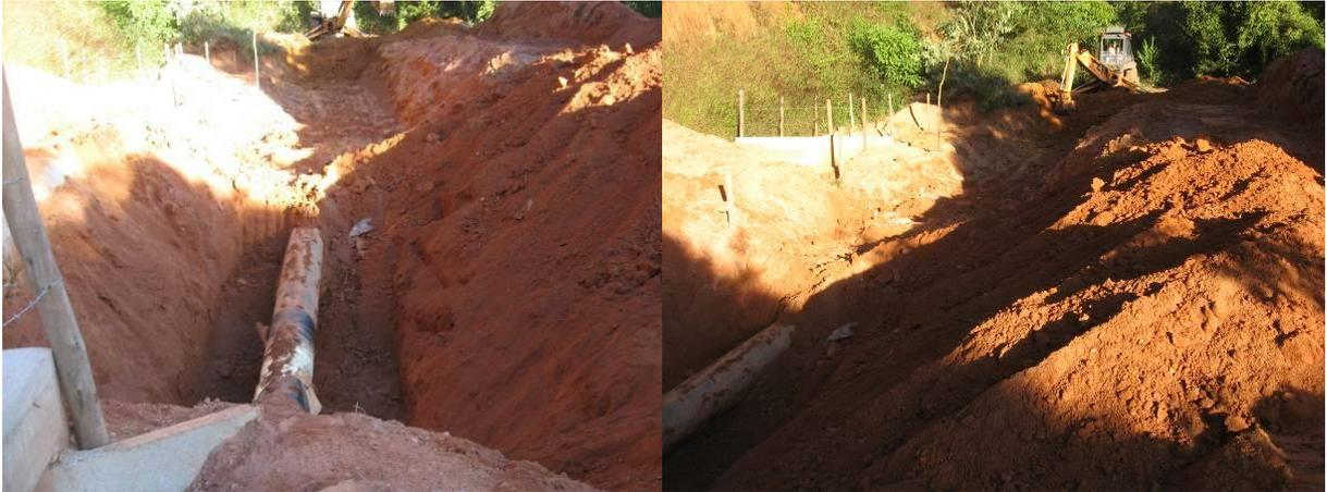
Figura 27: Abertura de vala para inspeção
