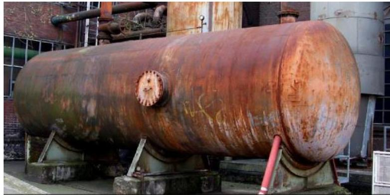
**Figura 4.2** - Corrosão uniforme em vaso de pressão (SANTOS, 2021)
