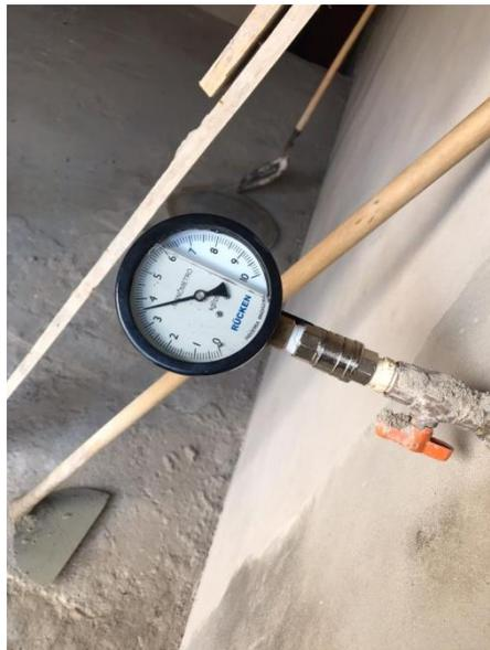
Figura 22: Medida de pressão em um ponto da rede do reservatório Metalúrgicos (AUTOR, 2019).
