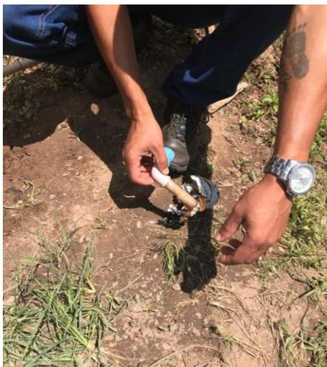
Figura 9: Aquecimento de um tubo PVC, para conexão com a saída da rede. O manômetro foi acoplado no Joelho azul rosqueado (AUTOR, 2019).
