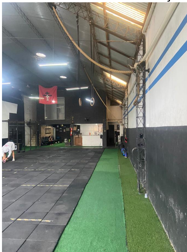
Figura 8 - Cobertura com telhas translúcidas do objeto de estudo.
