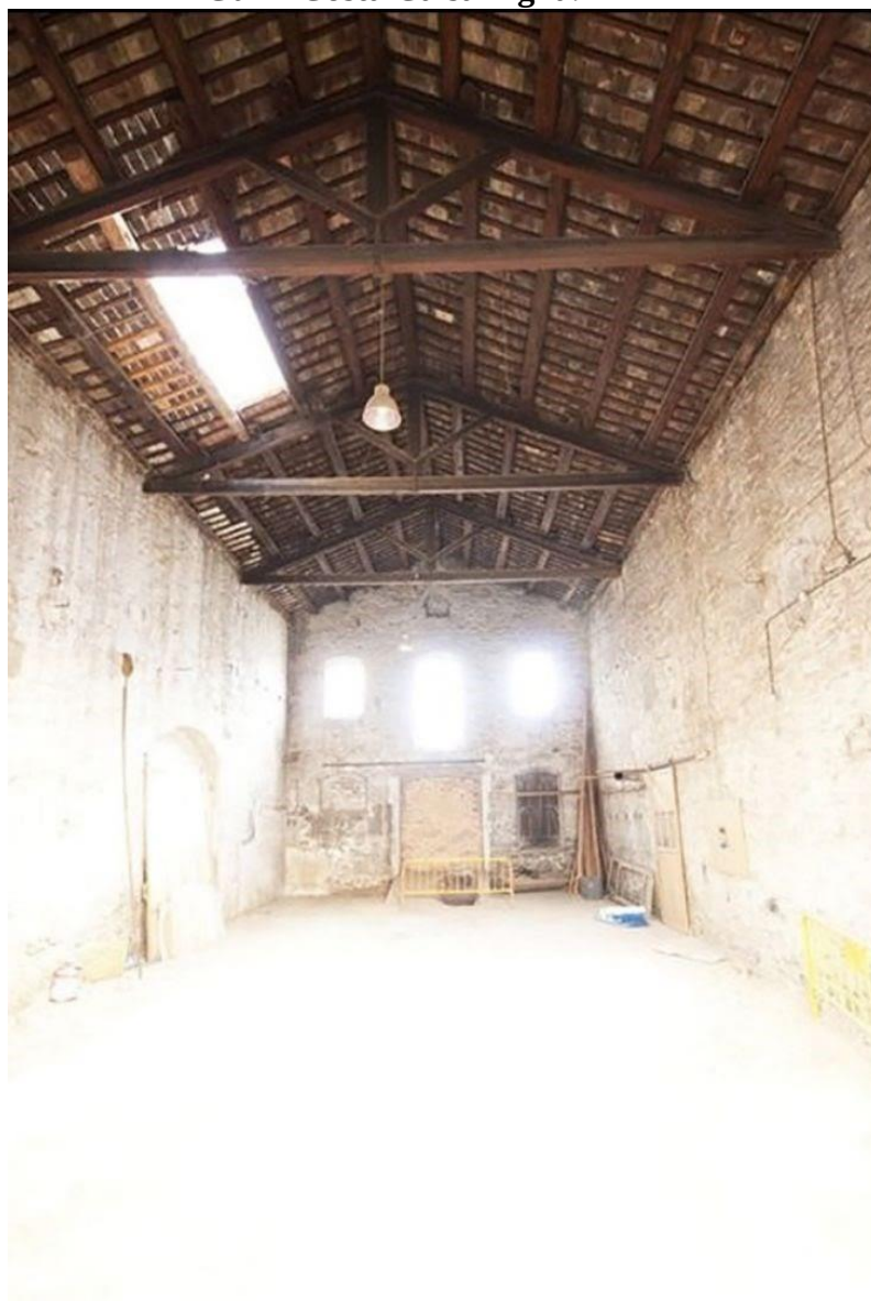
Figura 16 - Estado de conservação do galpão industrial referente ao projeto do arquiteto Guim Costa Calsamiglia.
