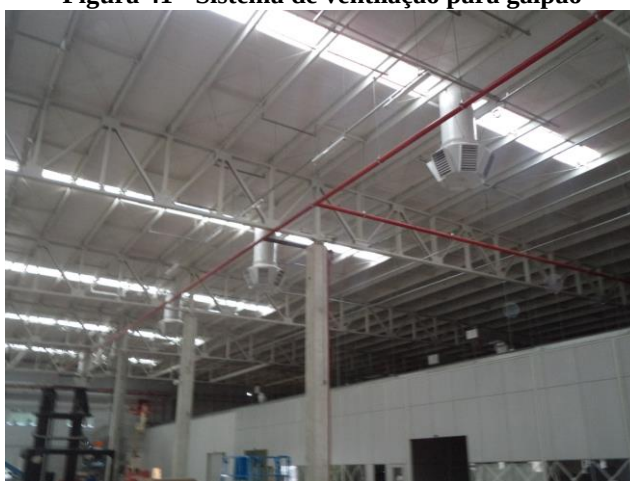
Figura 41 - Sistema de ventilação para galpão
