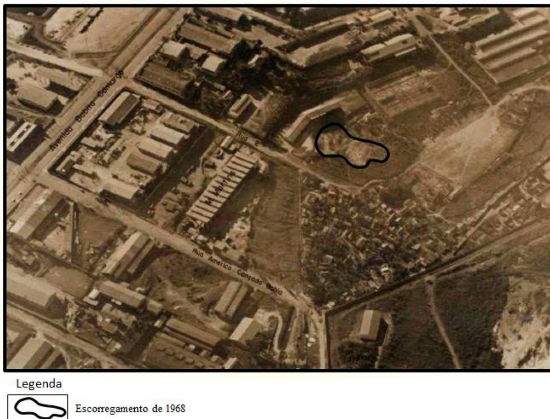
Figura 9: Deslizamento ocorrido na Vila Barraginha em 1968. Fonte: CETEC (1992).
