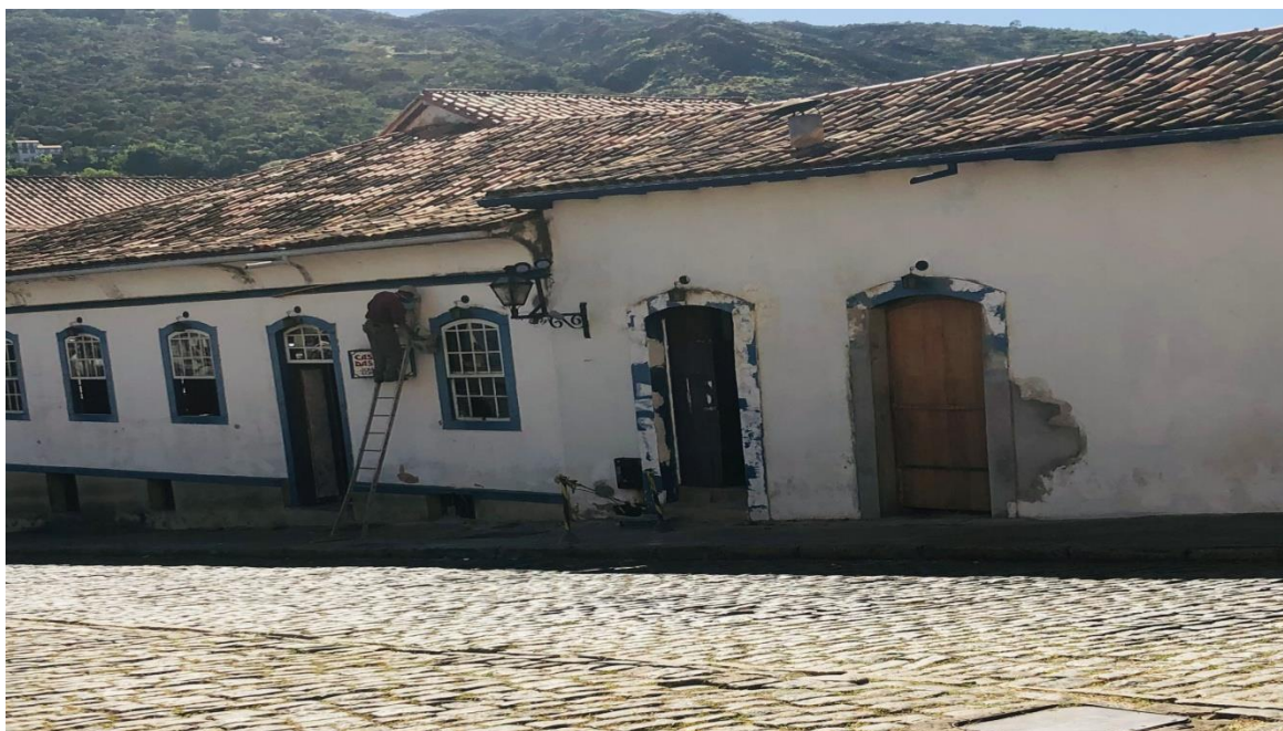
Figura 18: Casarão sendo reformado na Praça Tiradentes em Ouro Preto/MG.
