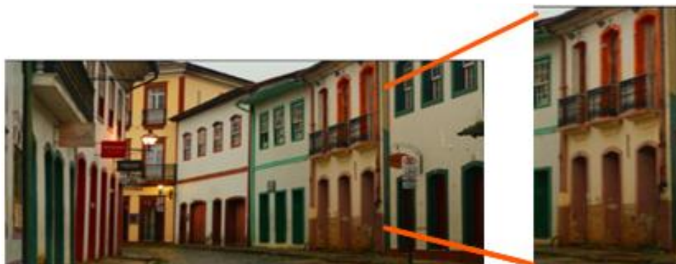
Figura 04: Casa sendo reformada e pintada de cor diferente do original em Ouro Preto/MG.
