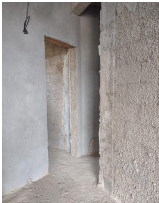
Figura 10 – Parede de alvenaria cerâmica chapiscada e rebocada a esquerda e somente chapiscada a direita.
