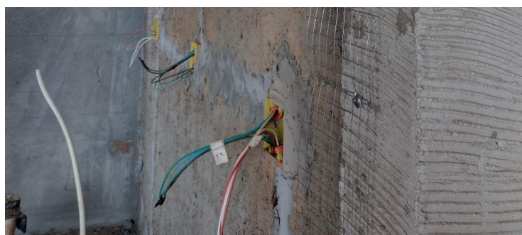
Figura 2 – Paredes de alvenaria de cerâmica preparada para receber o reboco.
