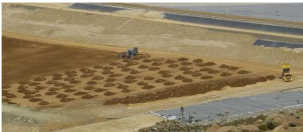
**Figura 6-** Empilhamento a seco de rejeitos com caminhões de transporte. Fonte: Engels (2006).
