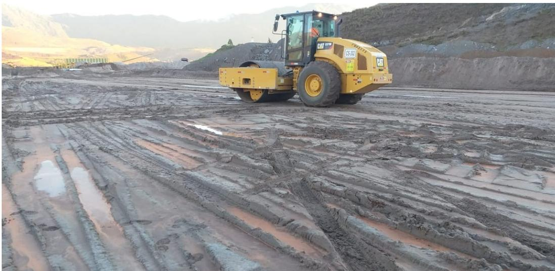
**Figura 8-** Processo de compactação com rolo compressor liso de rejeito filtrado. Fonte: Do autor.
