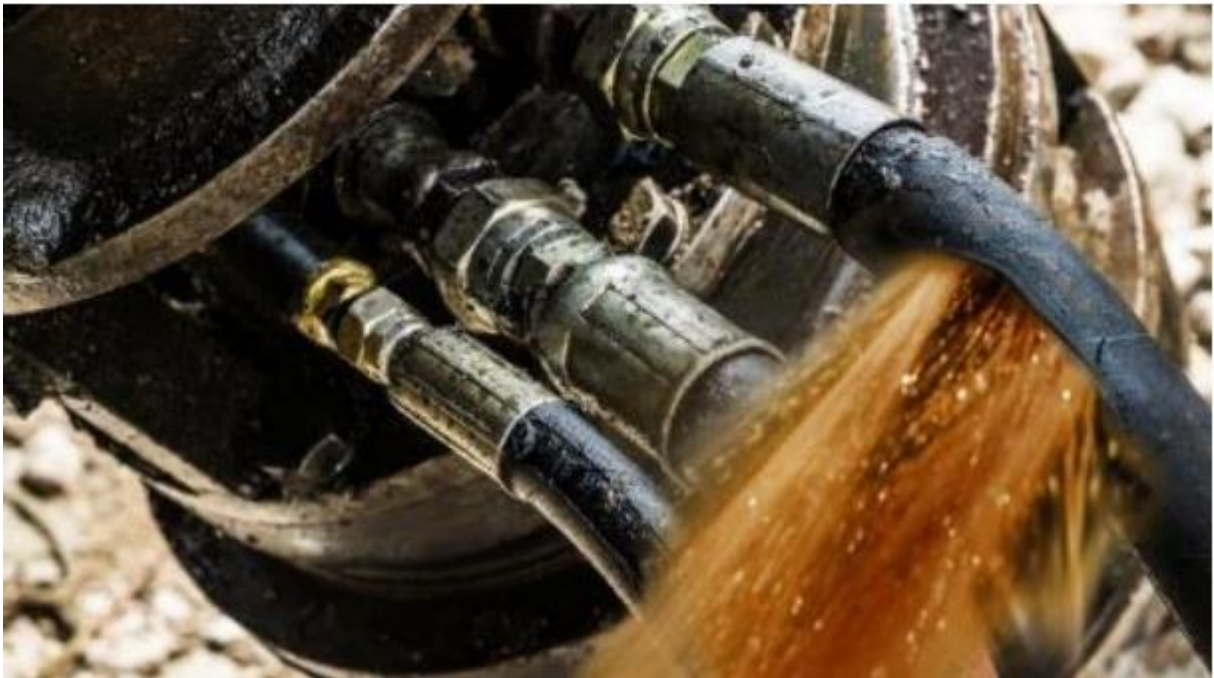
Figura 3 - Vazamento de óleo de uma mangueira do sistema hidráulico.
