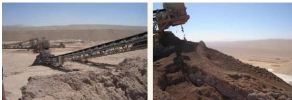
Figura 11 Disposição de rejeitos filtrado em Mantos Blancos (Guimarães, 2011).
