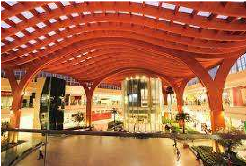
Figura 1: Cobertura em Madeira no Shopping Iguatemi de Fortaleza, CE.
