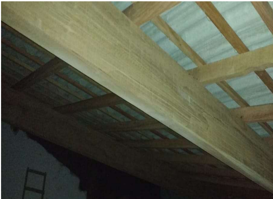
Figura 17: Estrutura de telhado em Cumaru na residência em Araxá.
