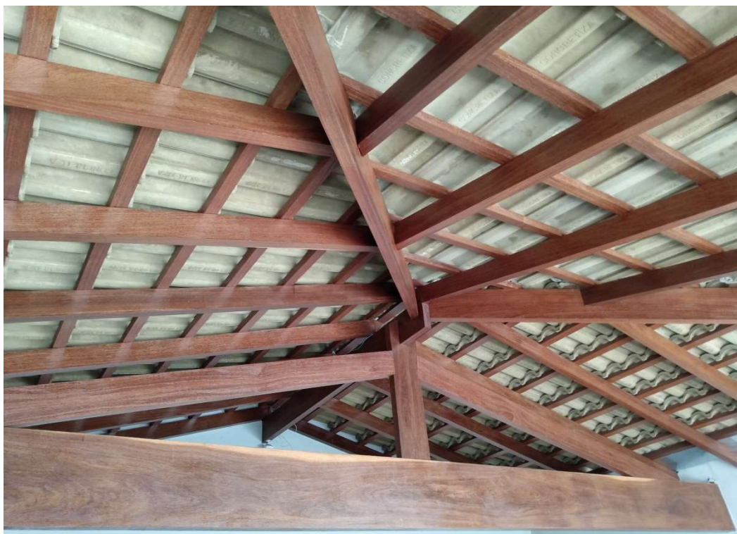
Figura 7: Estrutura de Telhado em Cumaru.
