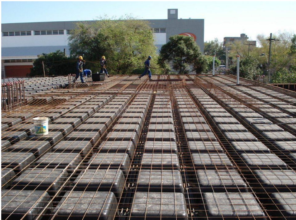
Figura 1 – Laje nervurada moldada no local
