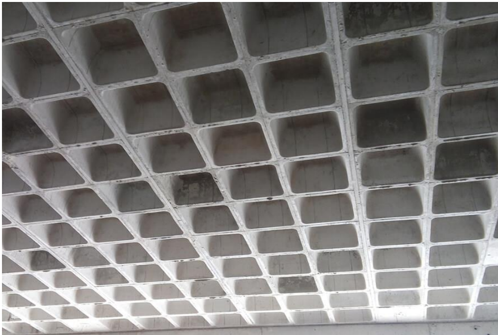
Figura 5 – Nervuras obtidas através de caixotes de polipropileno
