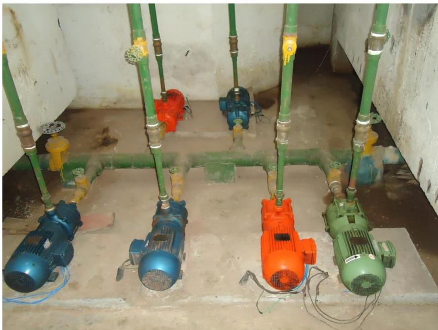
Figura 16: Bombas hidráulicas
