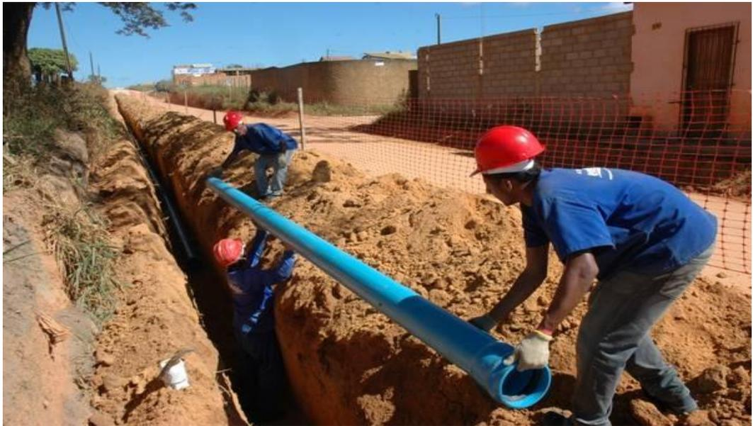
Figura 7: Assentamento da tubulação da rede de distribuição de água
