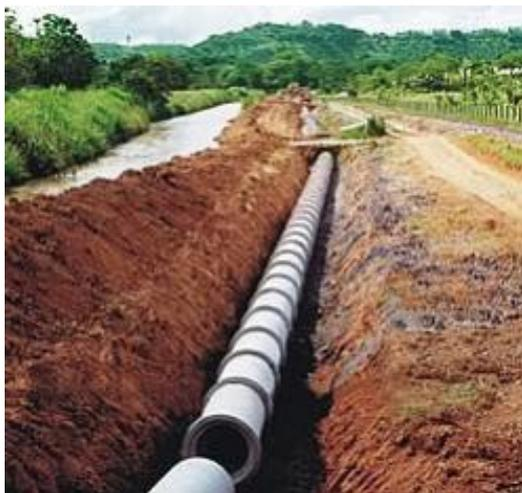
Figura 8 – Canalização de rede de água pluvial.
