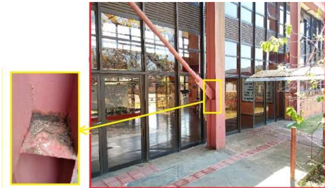
Figura 31: Coluna “ \Delta ”: inspecionada neste trabalho, onde está localizado o cordão H_2 (cordão horizontal). Fonte: Pesquisa direta, (2021).
