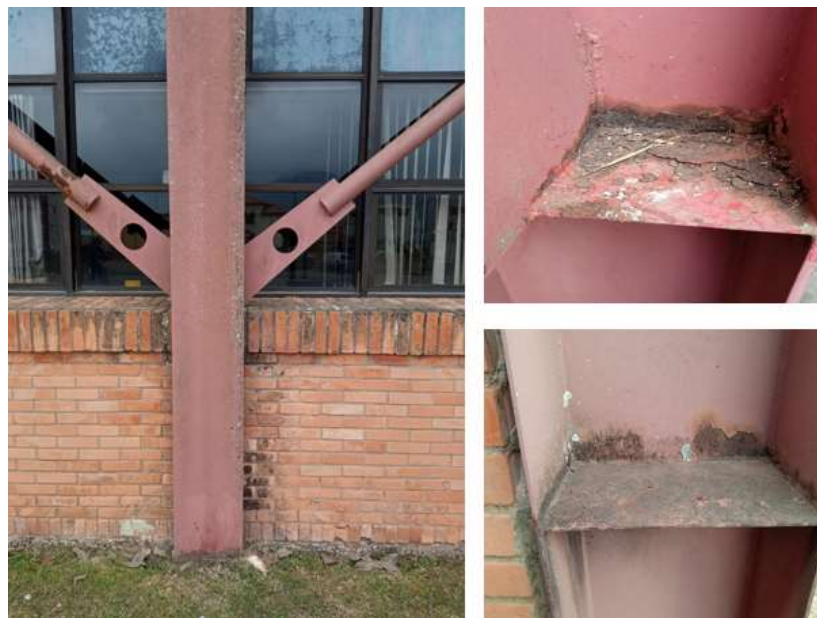
Figura 13: Região ensaiada da estrutura metálica da edificação. Fonte: Pesquisa direta, (2021).
