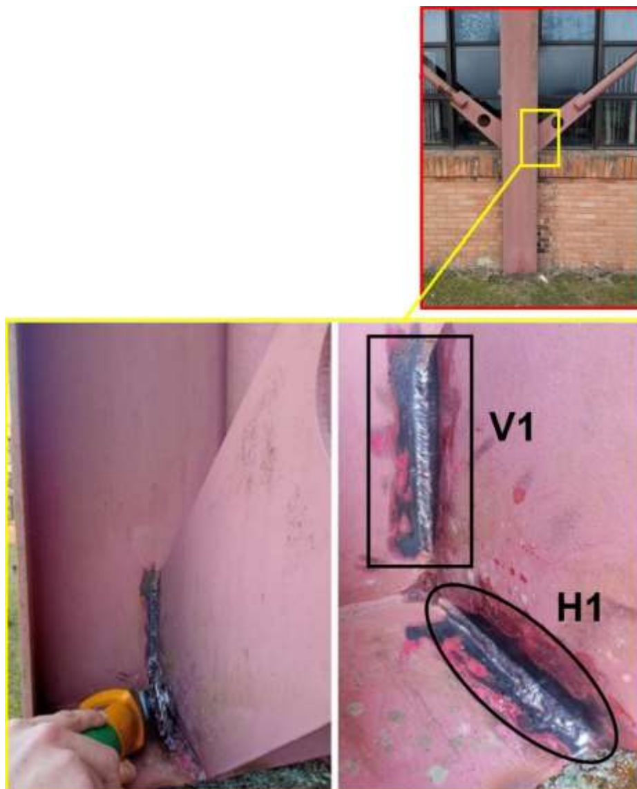
Figura 24: Cordões de solda inspecionados na coluna “X”: V1 (cordão vertical) e H1 (cordão horizontal).
