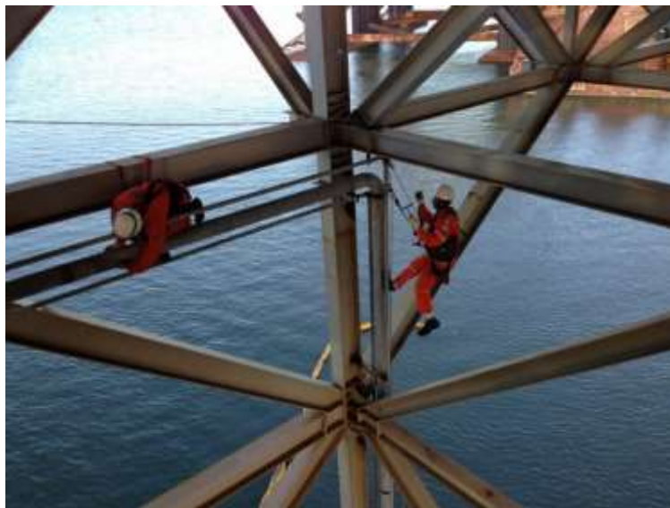
Figura 2: Diligência inspeção e manutenção, bem como pintura e impermeabilização em estrutura de difícil acesso.
