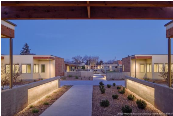
Figura 10 - Vista geral do projeto
