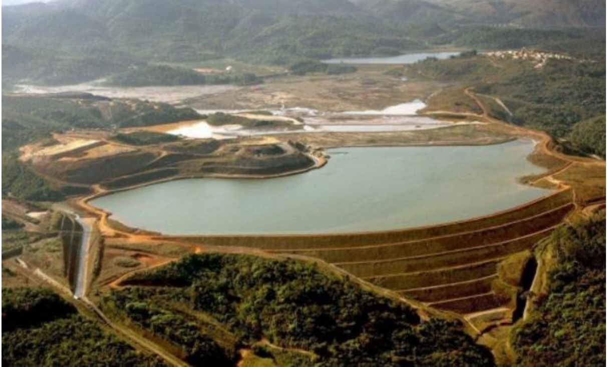
Figura 1: Barragem de rejeito Fonte: Geoscan (2020)
