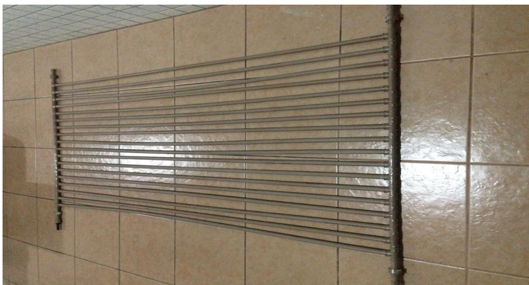
Figura 18 – Tubos no Processo Final de Colagem Fonte: Pesquisa direta (2015)
