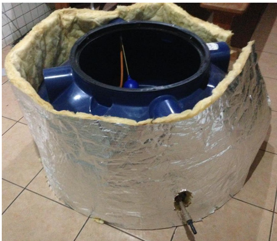
Figura 30 - Isolamento com Manta de Lã de Vidro Fonte: Pesquisa direta (2015)
