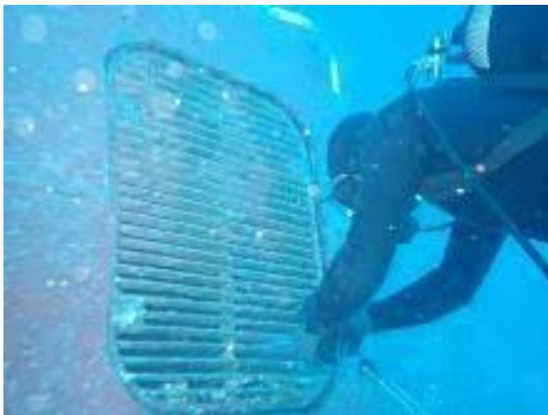
Figura 10: Entrada da caixa de mar sendo inspecionada.
