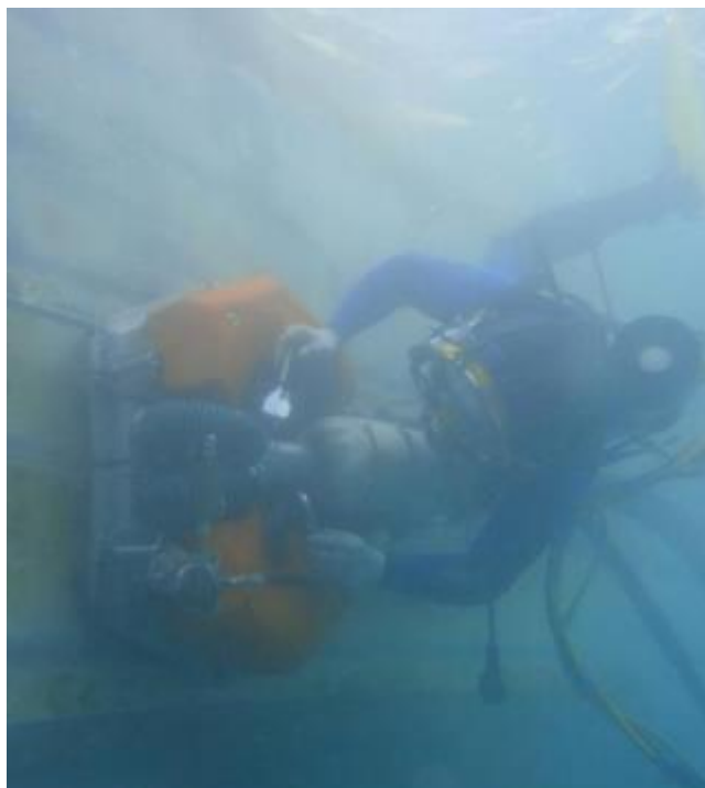
Figura 18: Ferramenta de limpeza em utilização.
