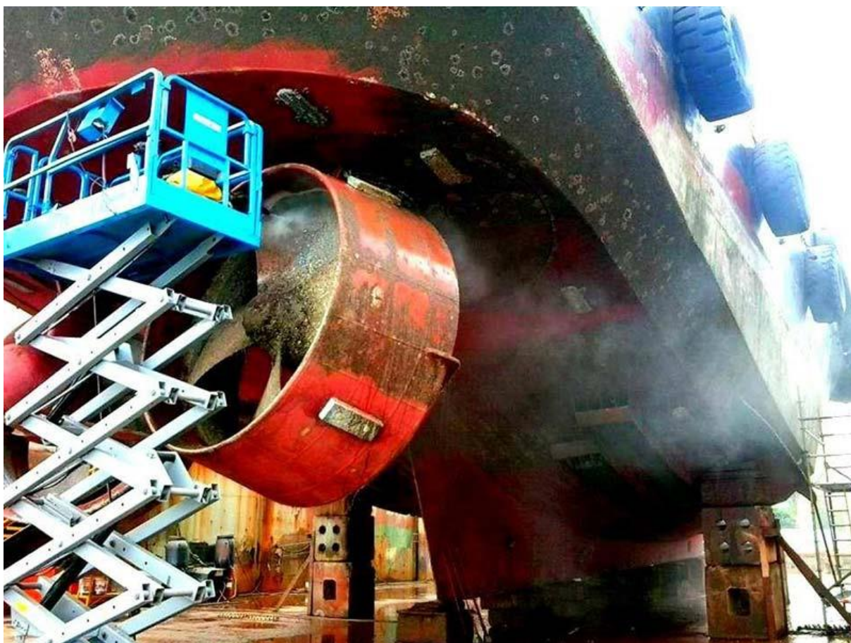
Figura 20: Exemplo de incrustação sendo removida com jatos de alta pressão.
