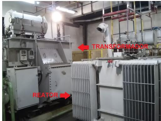
O reator limita a potência de curto-circuito do forno, resultando em menor queda de tensão no alimentador e ajuda na estabilização do arco, o que reduz o desgaste nos eletrodos (FILHO, 2015).
