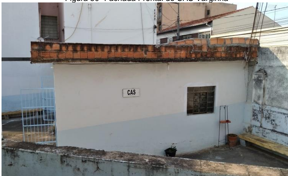
Figura 50- Fachada Frontal do CAS Varginha
