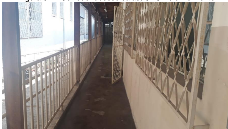
Figura 57 – Corredor acesso salas, CAS Belo Horizonte
