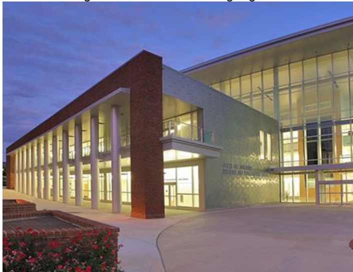
Figura 17 - Fachada com grandes aberturas - Language and Communication Center
