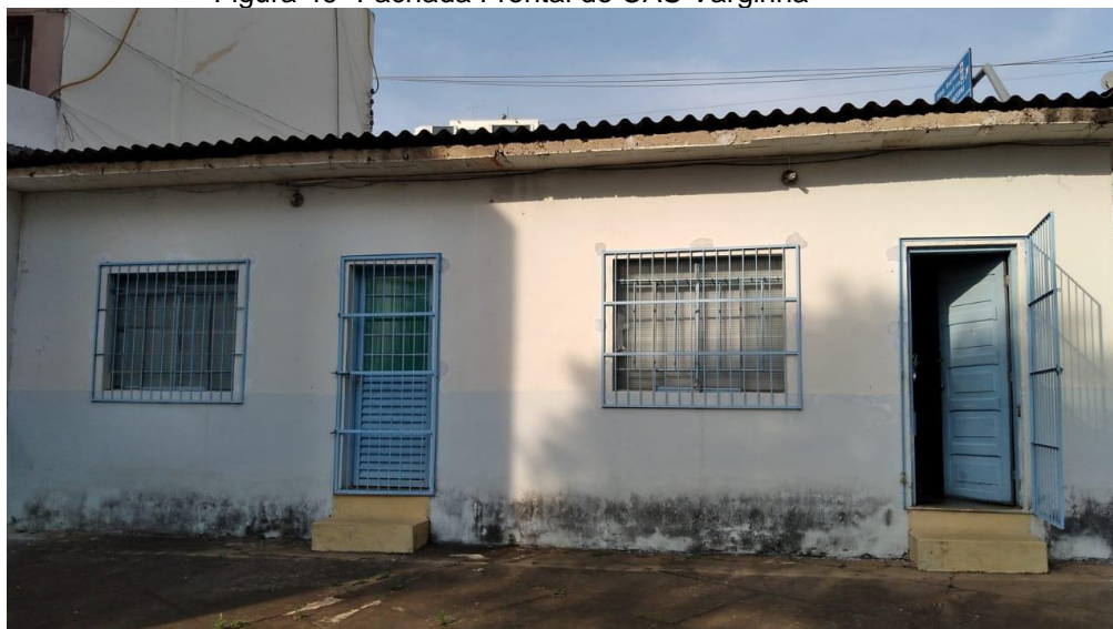
Figura 49- Fachada Frontal do CAS Varginha
