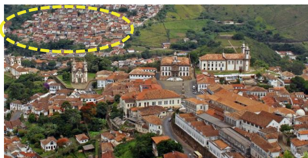
Figura 7: Centro histórico de Ouro Preto e, ao fundo, em destaque, bairro Vila Aparecida. Fonte: mineironaestrada.com.br.
