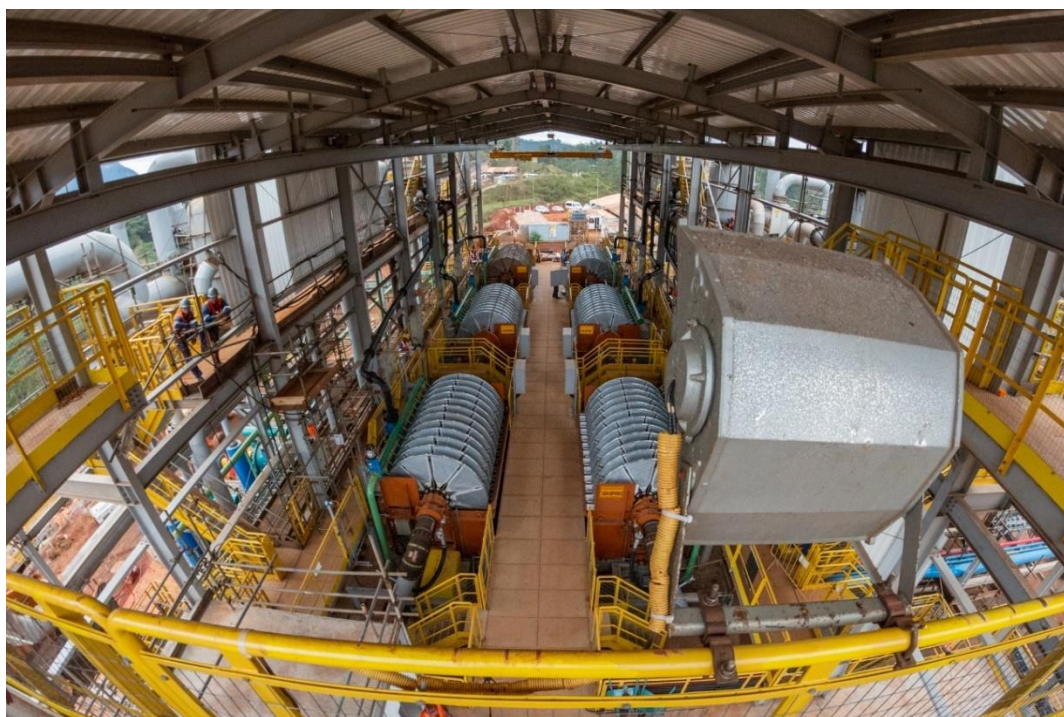
Figura 11 - Prédio da Filtragem
