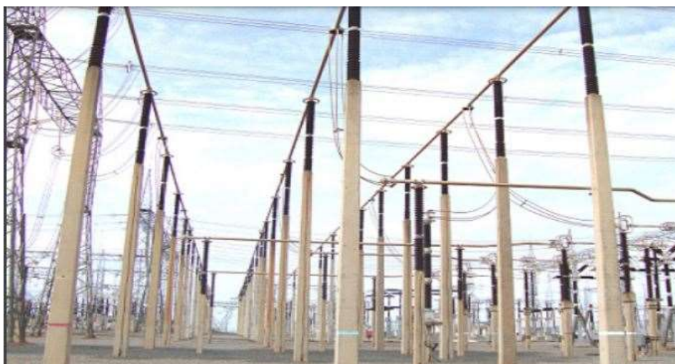
Figura 4 - Subestação de alta tensão.
