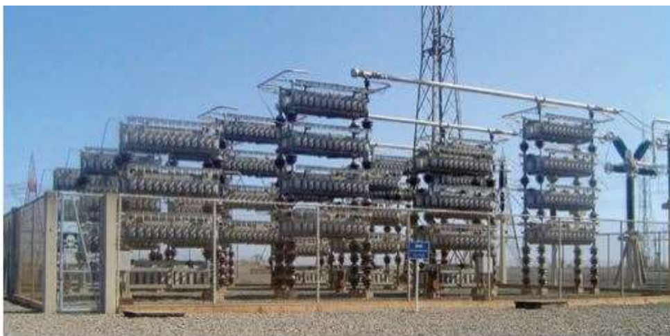
Figura 10 - Banco de capacitores usados em SE.
