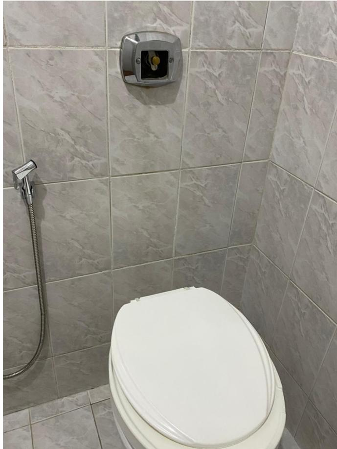
**Figura 12 - Vaso sanitário com descarga de válvula do banheiro social**
