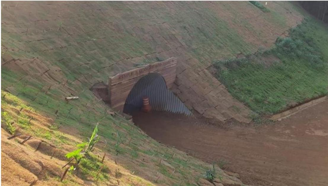
Figura 8 – Revestimento do talude com grama esmeralda
