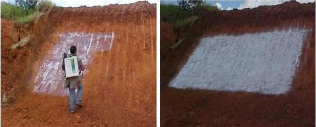
Figura 9 - Aplicação de calda fluída de cal com aglutinantes fixadores
