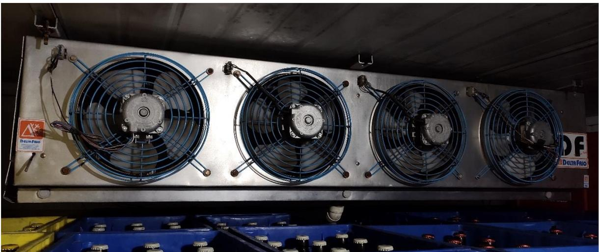
Figura 21: Unidade evaporadora Delta Frio modelo DF 15.47 da câmara 3.
