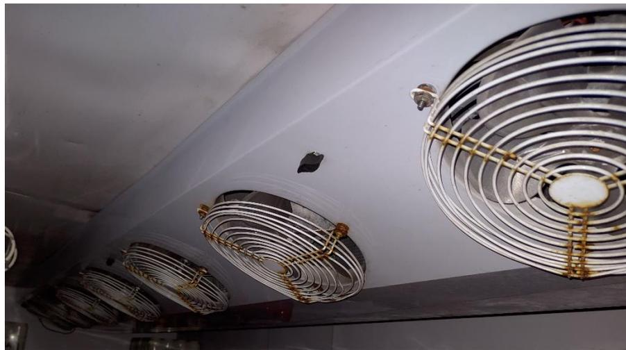
Figura 17: Unidade evaporadora Delta Frio modelo DFT 52.74 da câmara 2. Fonte: Pesquisa direta (2021).
