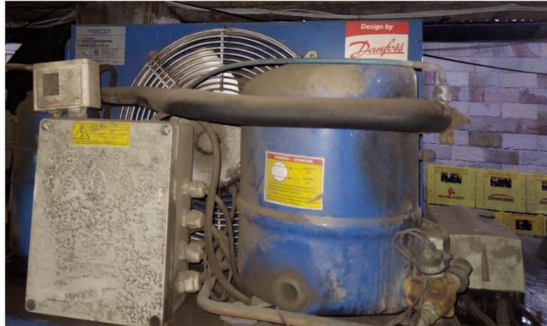
Figura 19: Unidade condensadora Danfoss modelo HCZ022B20N da câmara 2.
