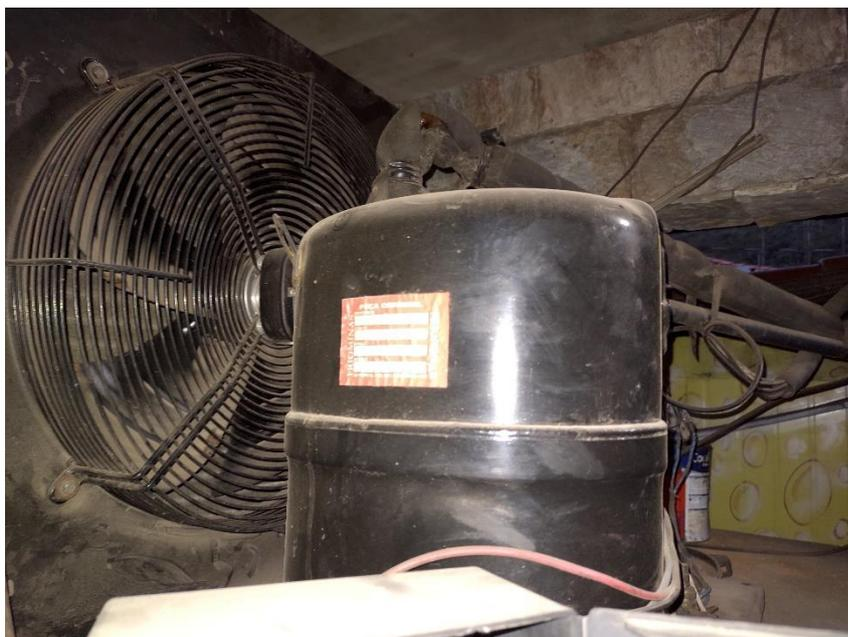
Figura 23: Compressor BRISTOL modelo H23A423ABCA da câmara 3.
