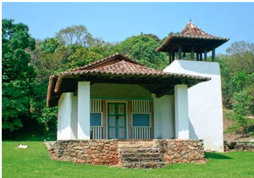
Figura 39: Capela Santo Antônio, São Roque - SP
