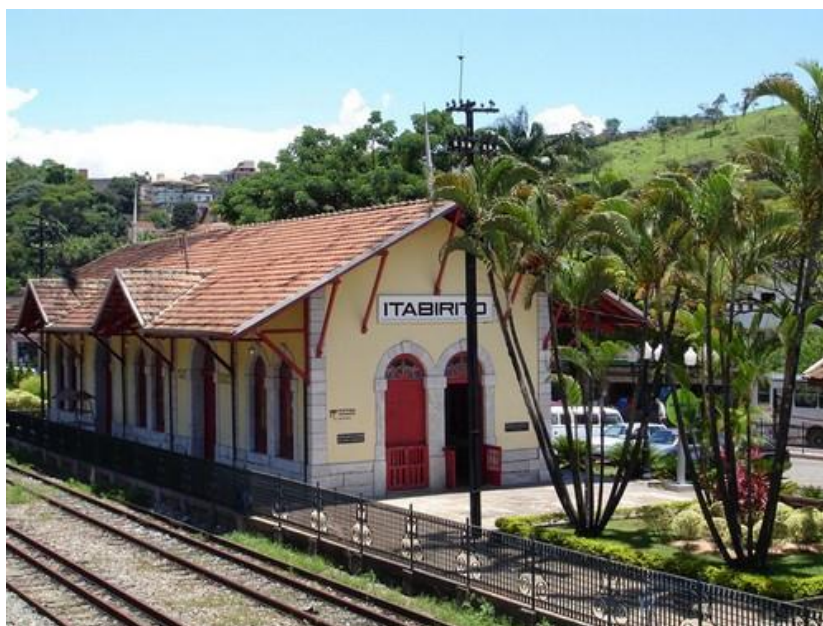
Figura 05: Estação Ferroviária, Itabirito - MG
