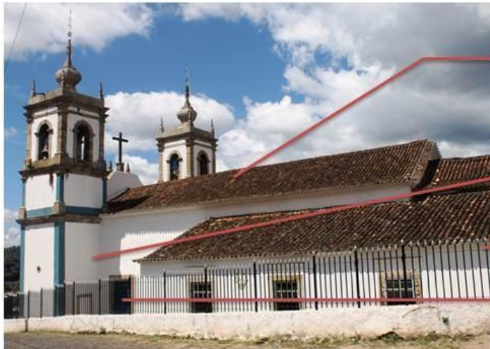
Fachada Lateral da Matriz.
