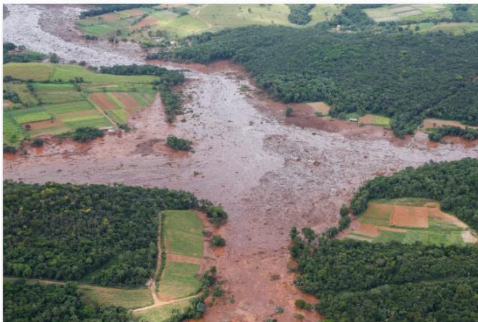
Figura 6: Barragem da mina do Córrego de Feijão após o rompimento
