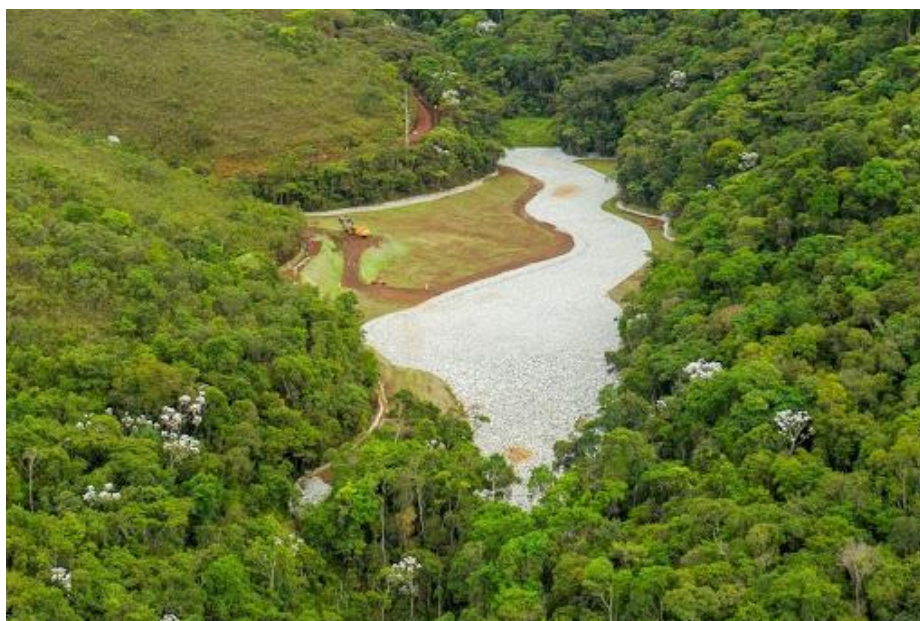
Figura 8: Barragem 8B - Vale - Depois da descaracterização
