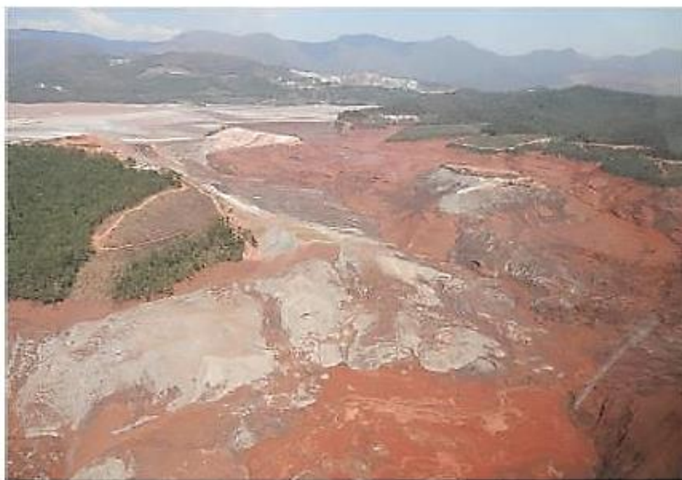
Figura 5: Barragem de Fundão após o rompimento
