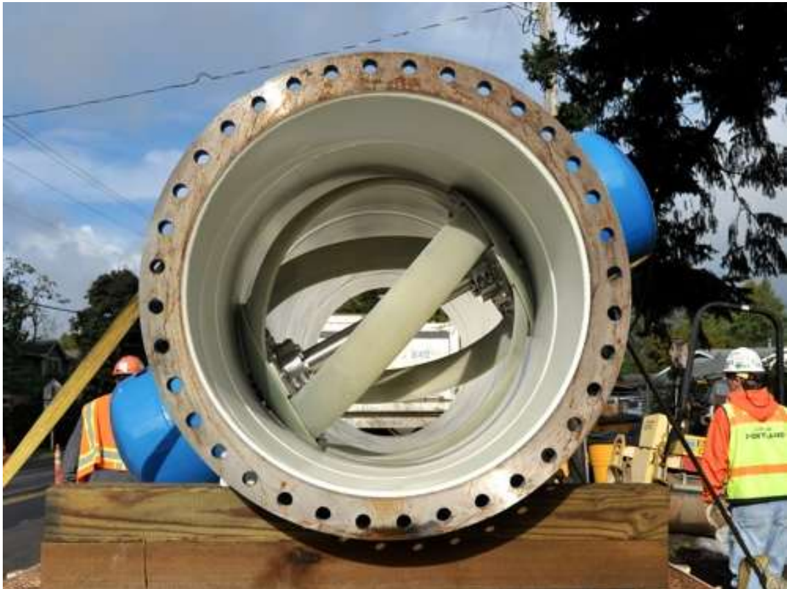
Figura 12 – Vista da turbina no interior de uma tubulação de 42” em Portland (LUCIDENERGY, 2017).
