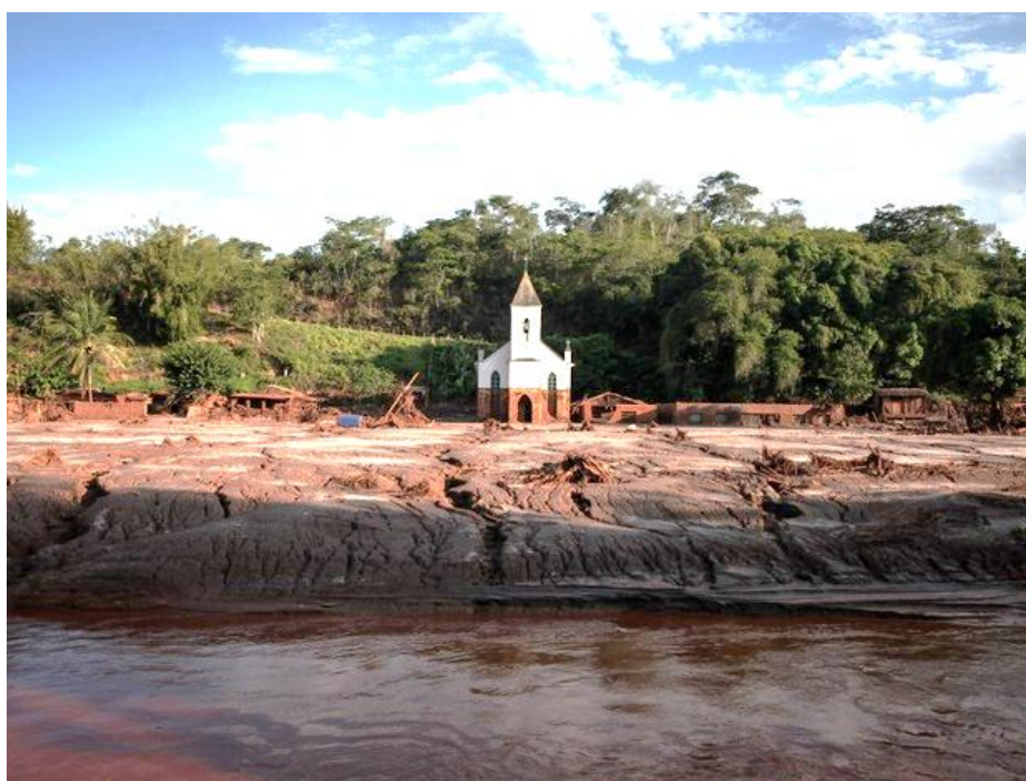
Figura 6 - Vila e igreja em Gesteira, na zona rural de Barra Longa (MG), sob a lama após o rompimento da Barragem de Fundão. Após o nível do rio descer, a marca de lama pode vista no alto da fachada da Capela Nossa Senhora da Conceição. À direita da capela está a antiga escola da comunidade (Foto: Fábio Tito/G1)
