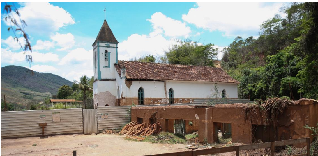
Figura 34 – Local exato de aplicação do projeto. Ao fundo, a Capela de Nossa Senhora da Conceição, construída em 1891. Ao lado da capela, a antiga escola comunitária em ruínas. Nota-se que o nível do solo se encontra acima do normal, uma vez que as aberturas (portas e janelas) estão impedidas (Disponível em < https://agenciabrasil.ebc.com.br/geral/noticia/2017-11/vilarejos-para-reassentar-vitimas-da-tragedia-de-mariana-nao-sairam-do-papel > Acesso em set. 2019)
