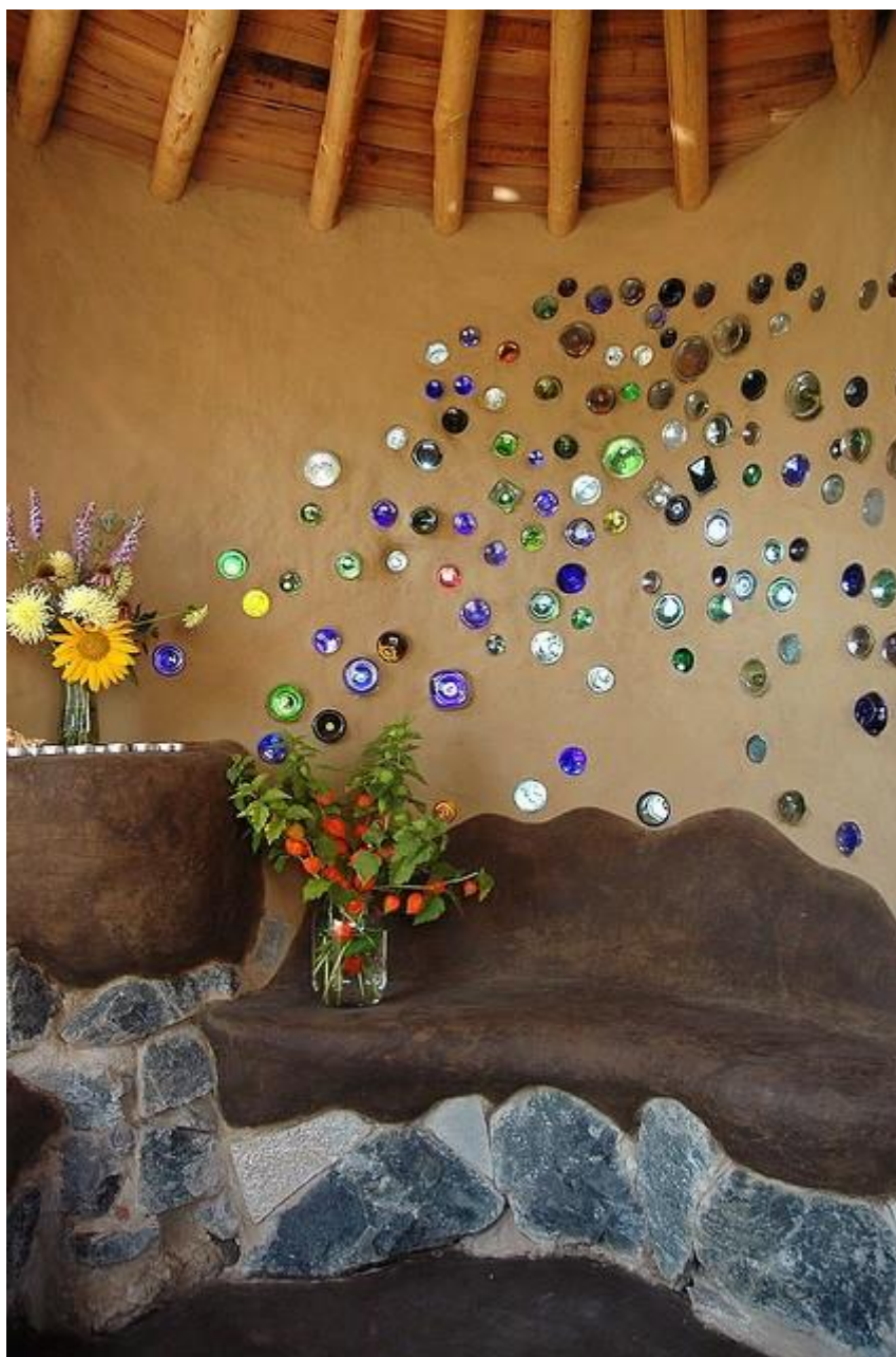
Figura 18 – Garrafas de vidro utilizadas em paredes de COB para decoração e pontos de iluminação (Disponível em < http://www.sustentaacoes.com/2016/02/vamos-construir-um-mundo-melhor.html > Acesso em ago. 2019)
