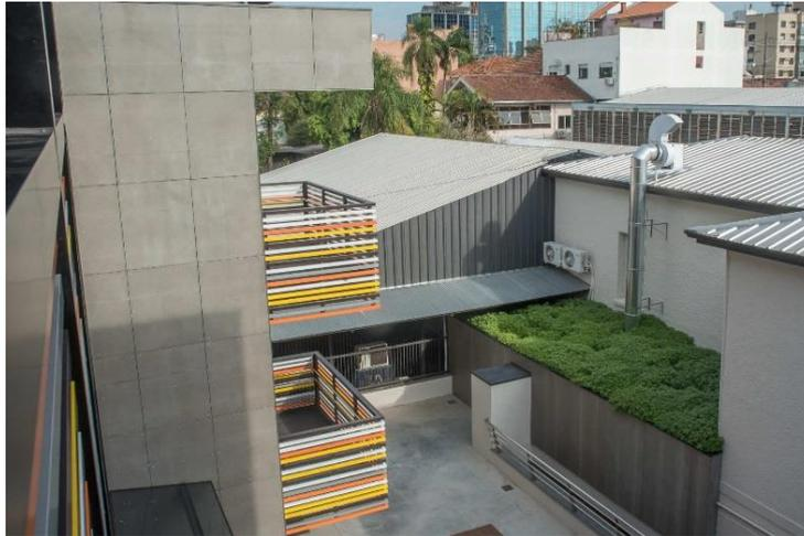
Figura 21: Aplicação do sistema hidromodular no telhado
