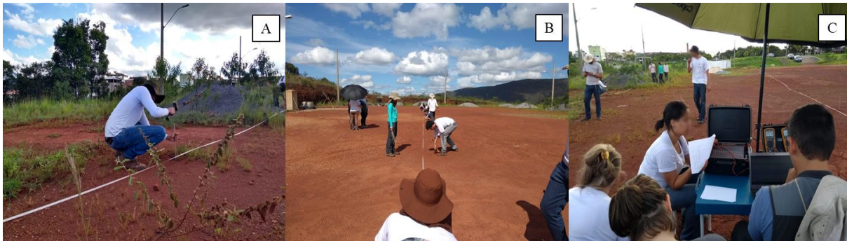
Figura 6.6 – A) Medição da área com auxílio de trena para estaqueamento das posições dos eletrodos. B) Instalação dos eletrodos nos pontos demarcados com auxílio de marreta. C) Coleta de dados via resistivímetro a partir da estação de trabalho.
